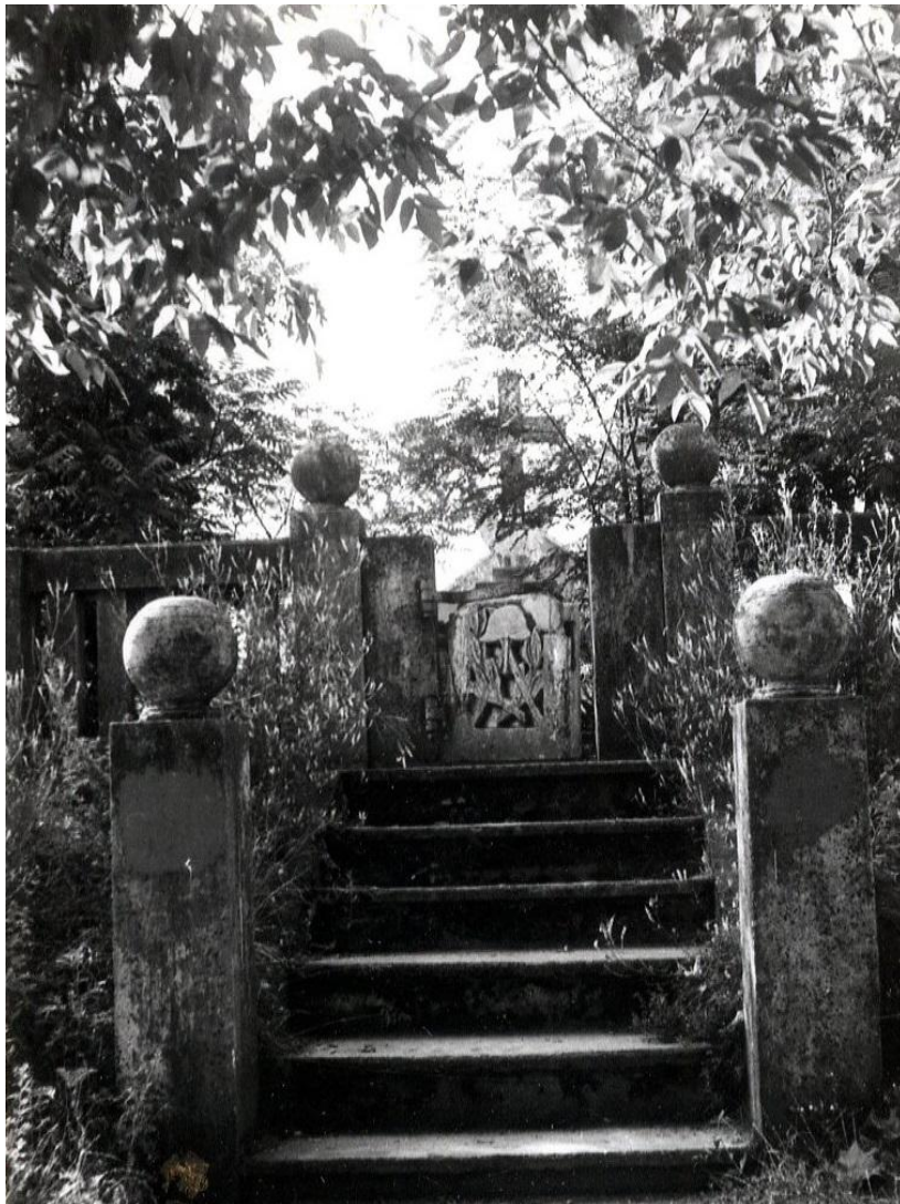
Fot.7 Zniszczone schody na kopiec i furka betonowa, fotografia z 1987r. wykonana przez C. Kiełboń i E. Sadowska.
