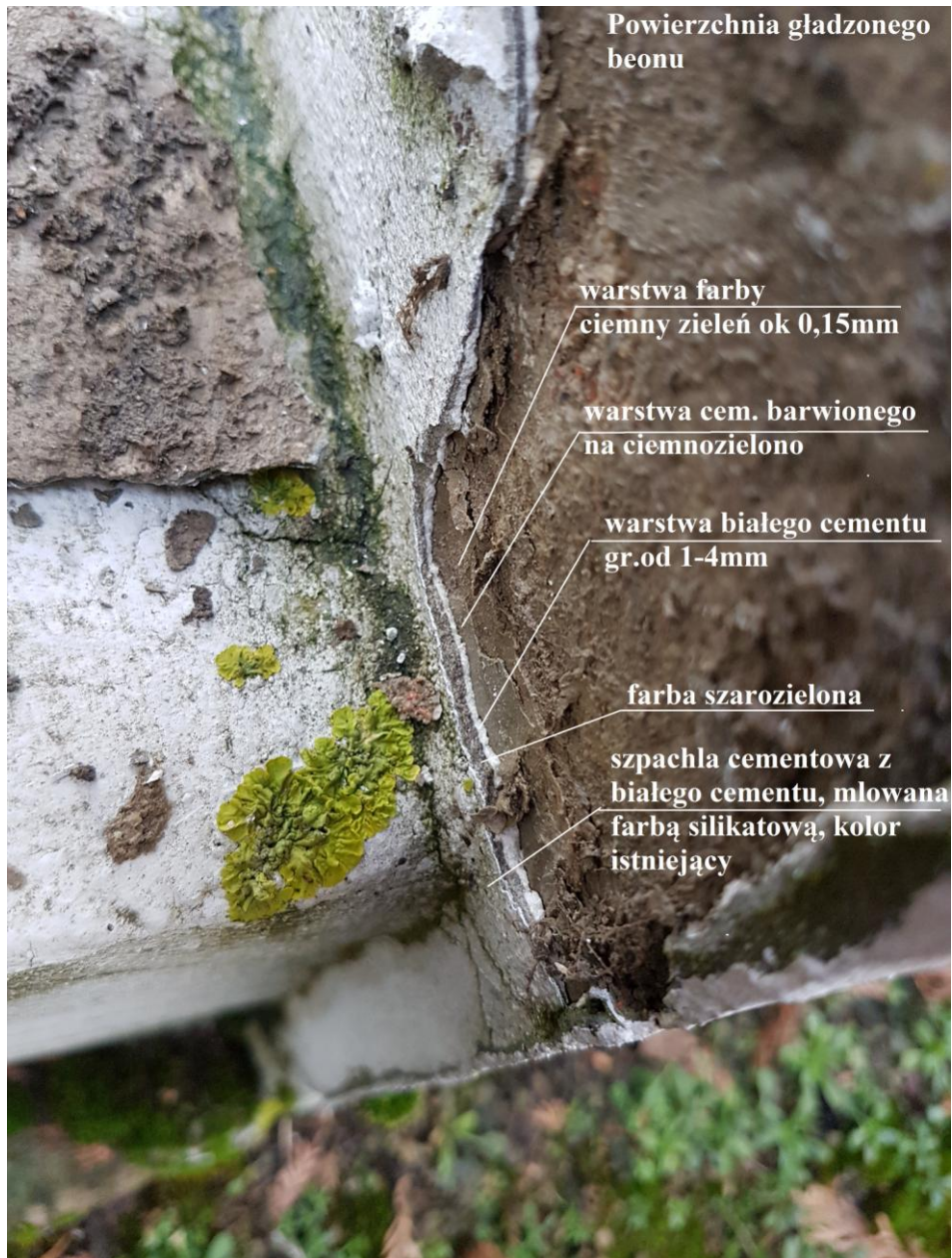
Fot. 13 Warstwy wykończeniowe betonowego ogrodzenia.
