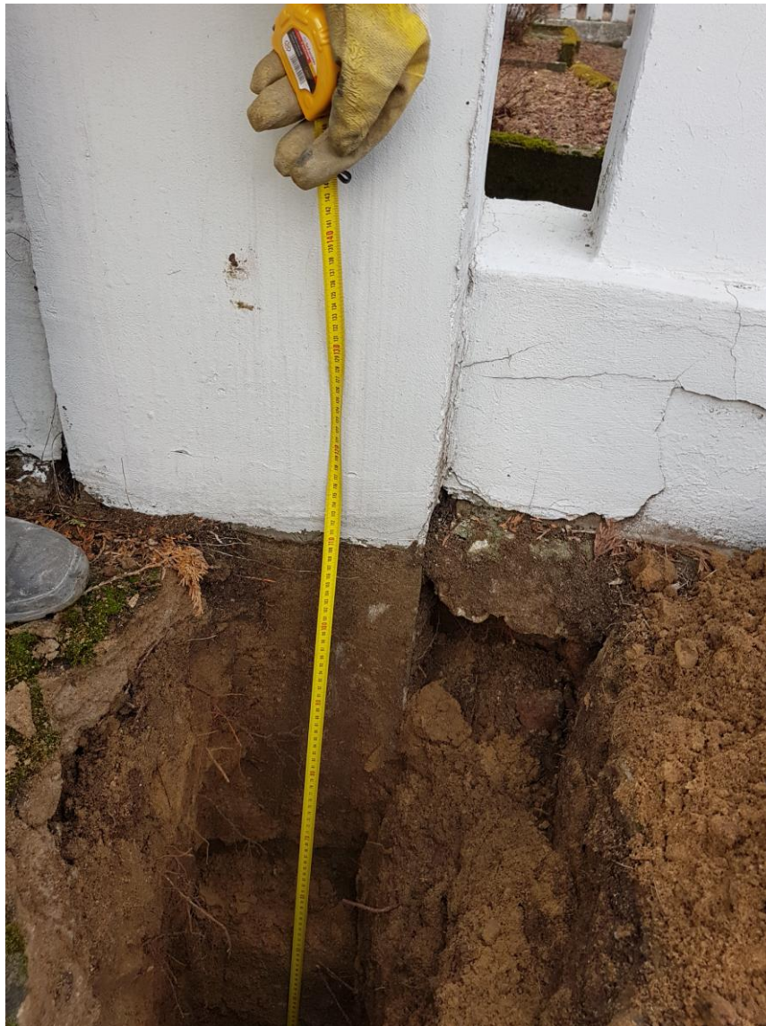
Fot.9 Szczegół oparcia słupa na stopie fundamentowej
