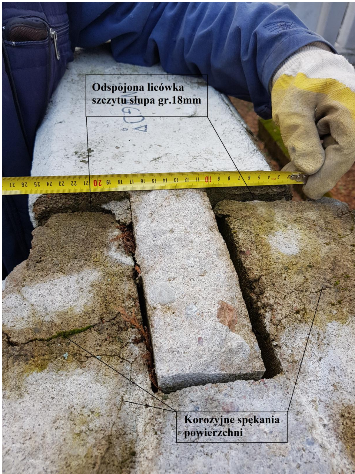
Fot.11 Szczegół połączenia belki poręczowej ze słupem.
