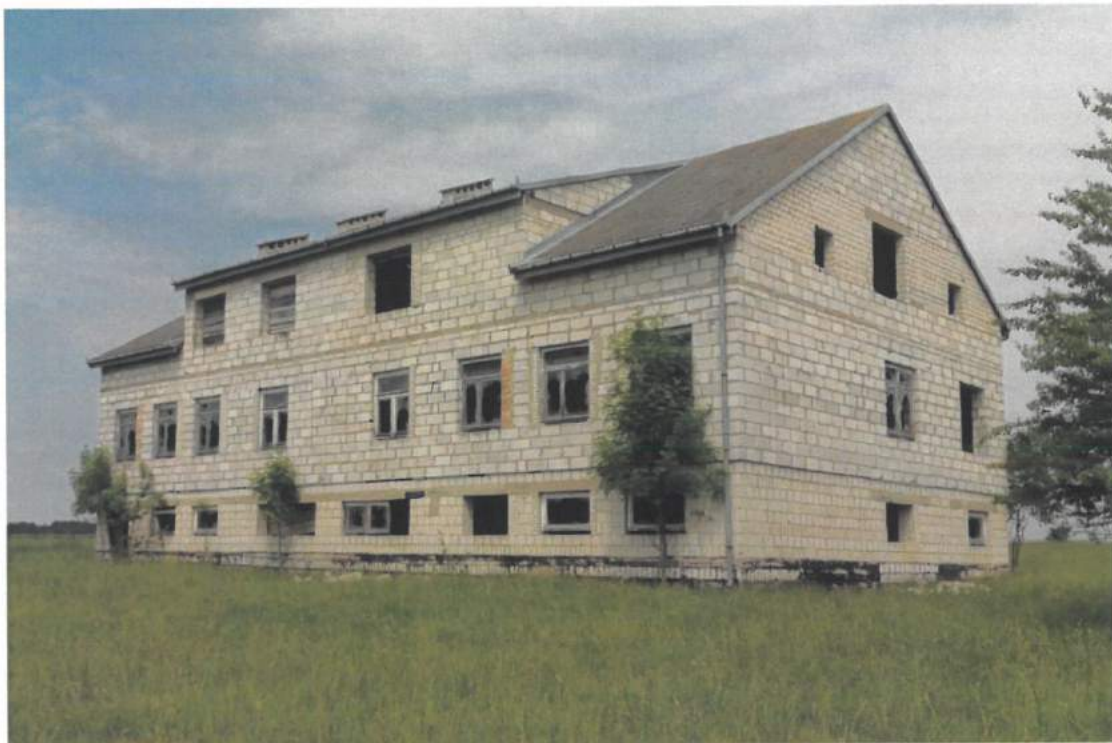
Fot. 1 Widok od strony elewacji frontowej
