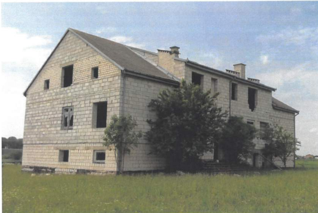
Fot. 2 Widok od strony elewacji tylnej
